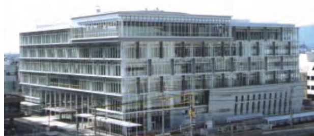
岩国市役所本庁舎
